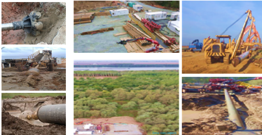
Instalare conductă transport fluide prin metoda HDD
